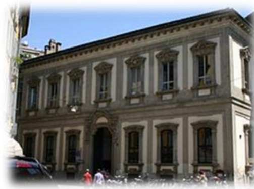
Palazzo delle ex Scuole Arcimbolde
